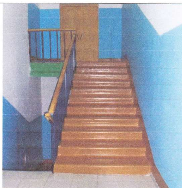
Фото № 12 Лестницы внутри здания
