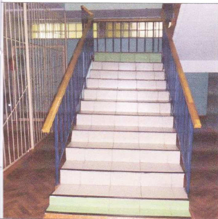
Фото № 11 Лестницы внутри здания
